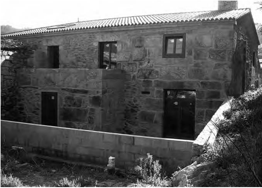
La casa de A Silva rehabilitada.
